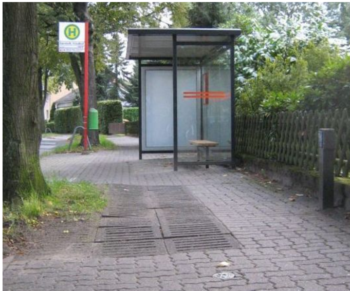
Abbildung 18: 2007 Erbautes Bushaltestellenhaus auf dem benutzungspflichtigen Radweg in der Ochsenzoller Straße
