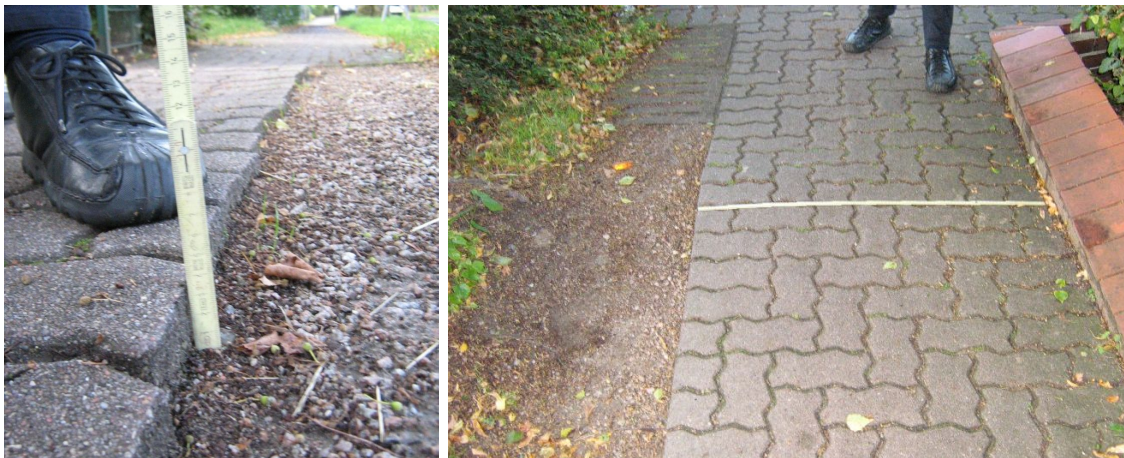
Abbildung 16: 4(!) Zentimeter tiefe Längsrille auf dem „gemischten“ Zweirichtungsweg
