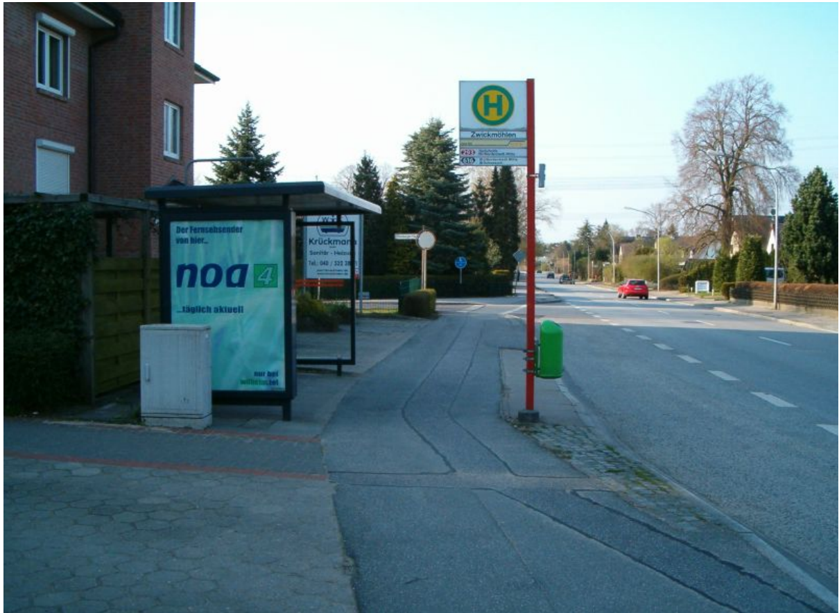
Radwege sind multi-funktionell! Zweirichtungsradweg, Fußweg und Bushaltestelle in einem! Geht doch!
